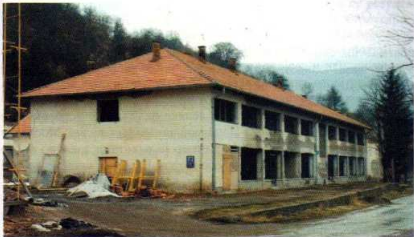
Зграда Опћине у вријеме реконструкције
