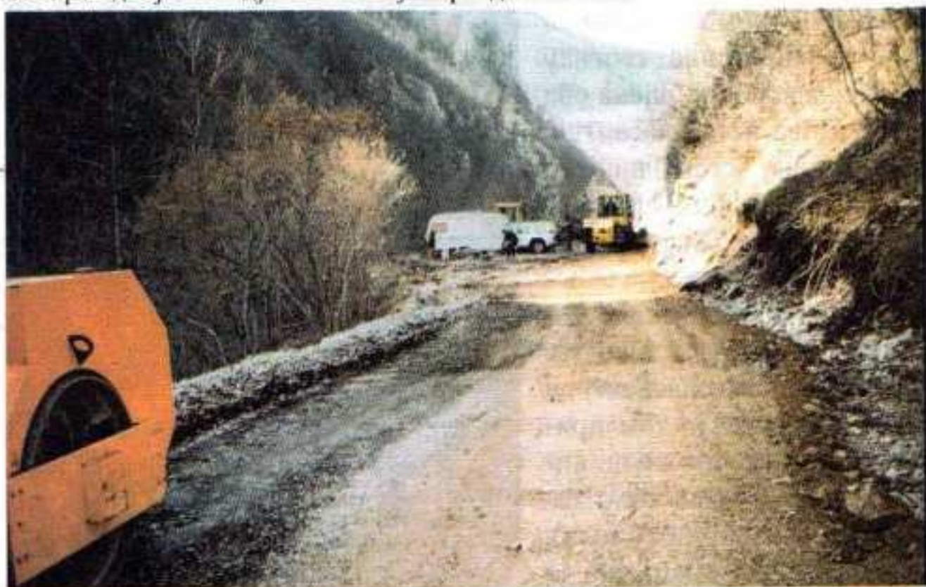
Механизација на раду трасе изградње пута
