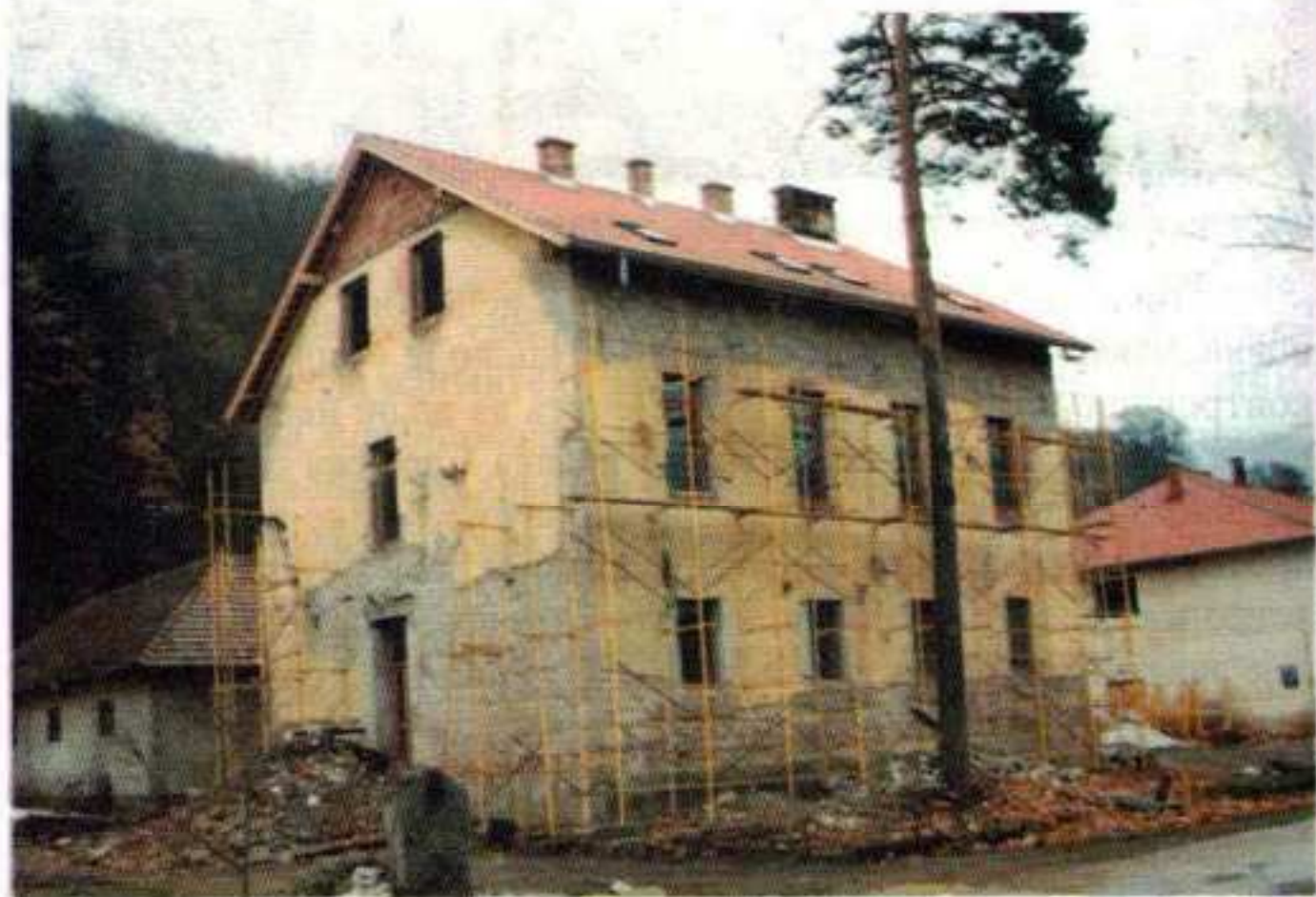
Зграда полиције у Прачи у вријеме реконструкције
