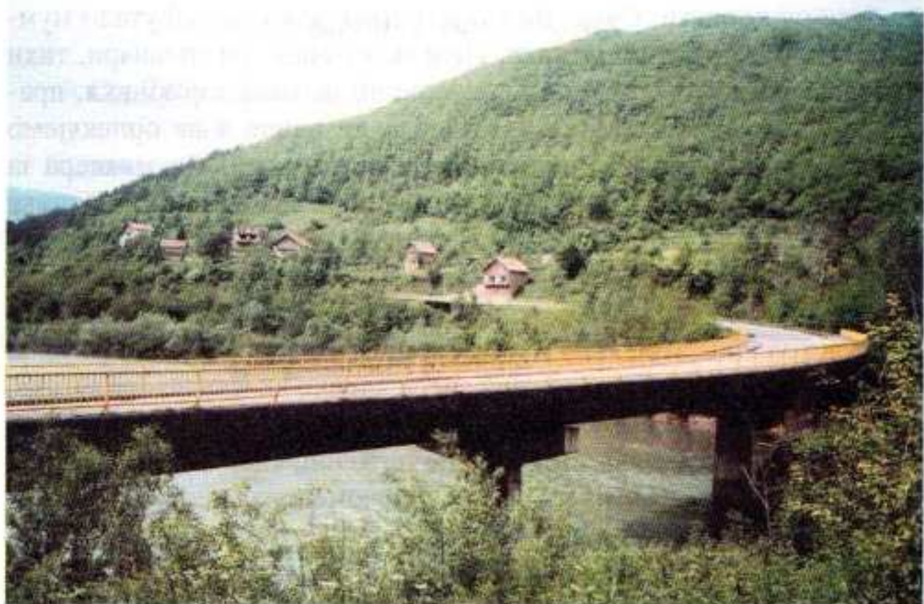
Посљедњи мост на ријечи Прачи (пут Устипрача - Горажде)
