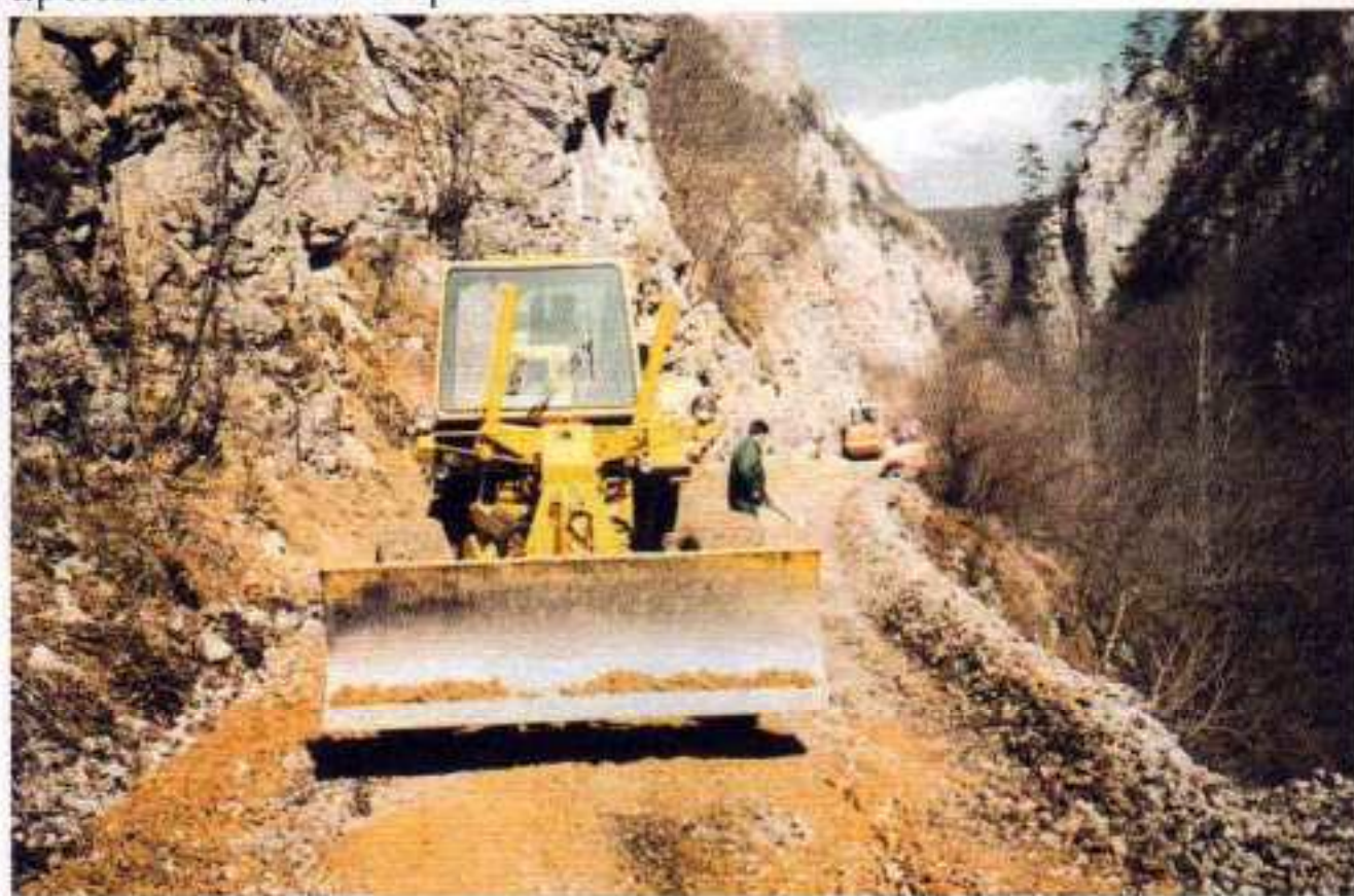
Равнање пута помоћу булдожера
